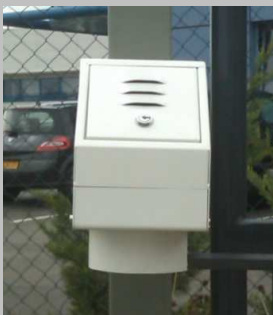
Carter anti pince doigts protégeant les fins de course
